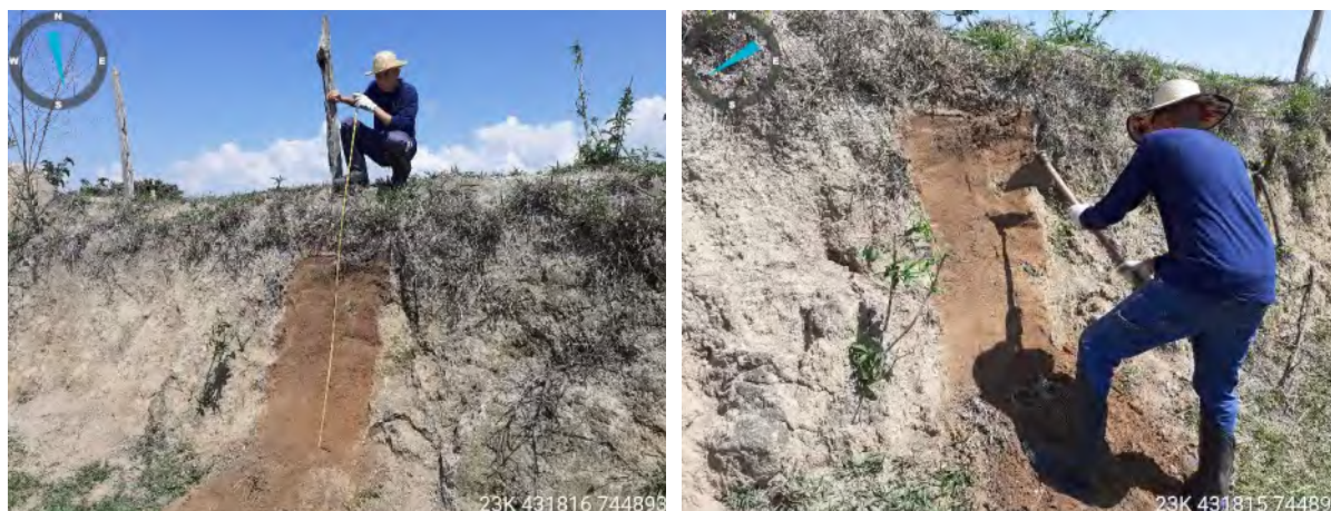
Figuras 4.10 e 4.11: Retificação / reavivamento de perfil estratigráfico no local de implantação do PT076.
