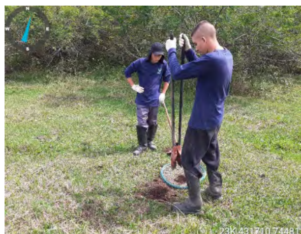
Figuras 4.20 e 4.21: Abertura do poço-teste com auxílio de cavadeira manual tipo boca de lobo (PT's 012 e 067, respectivamente).
